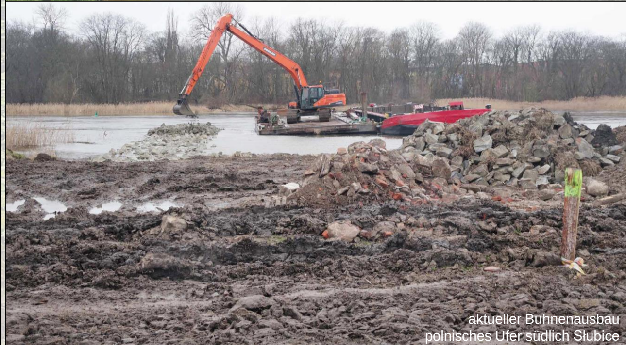
alter Bühnenverbau vom polnischen Ufer in Richtung Oderinsel Küstrin-Kietz
